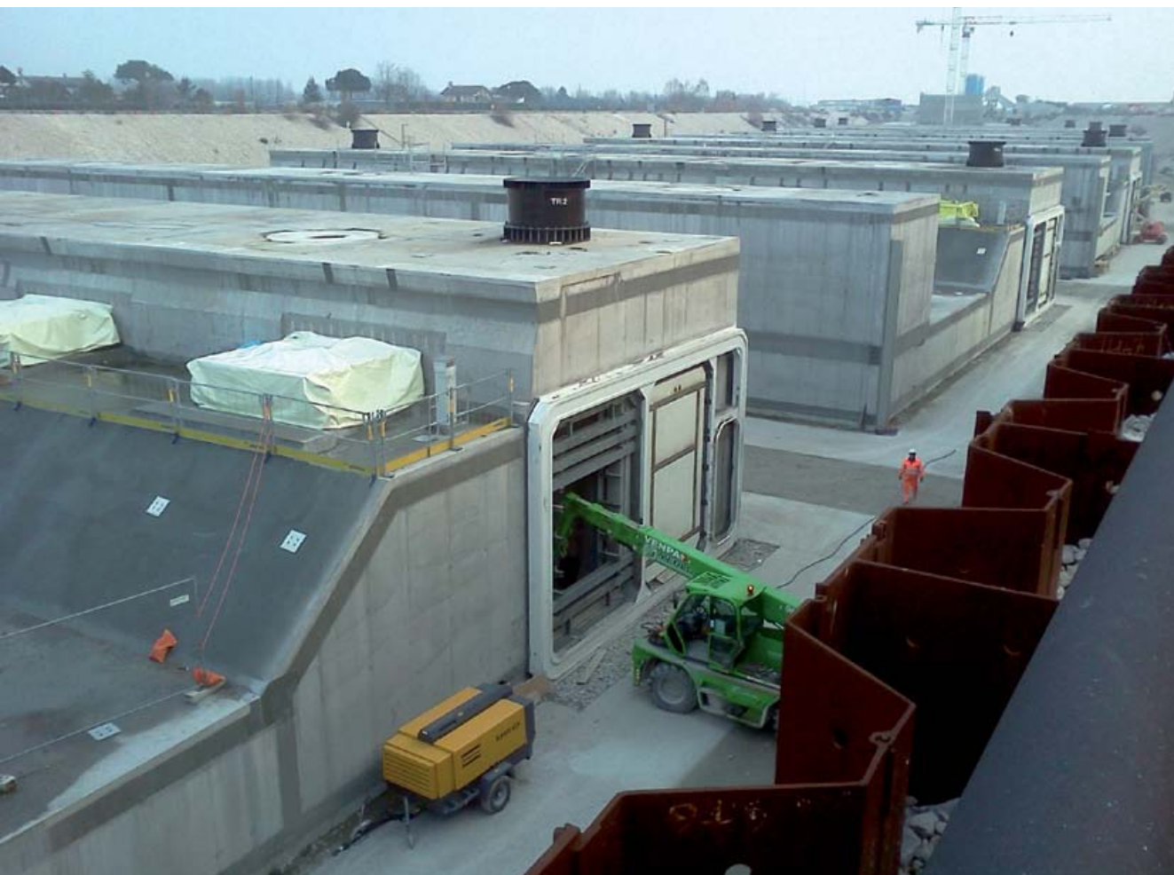
Slika 18: Gradbišče zapornic projekta MOSE za varovanje mesta Benetke v Italiji pred poplavami (Tomaž Berčič).
