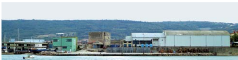
Slika 77: Stavbe na vzhodnem industrijskem območju Izole leta 2012 (Diederik Giesen).
