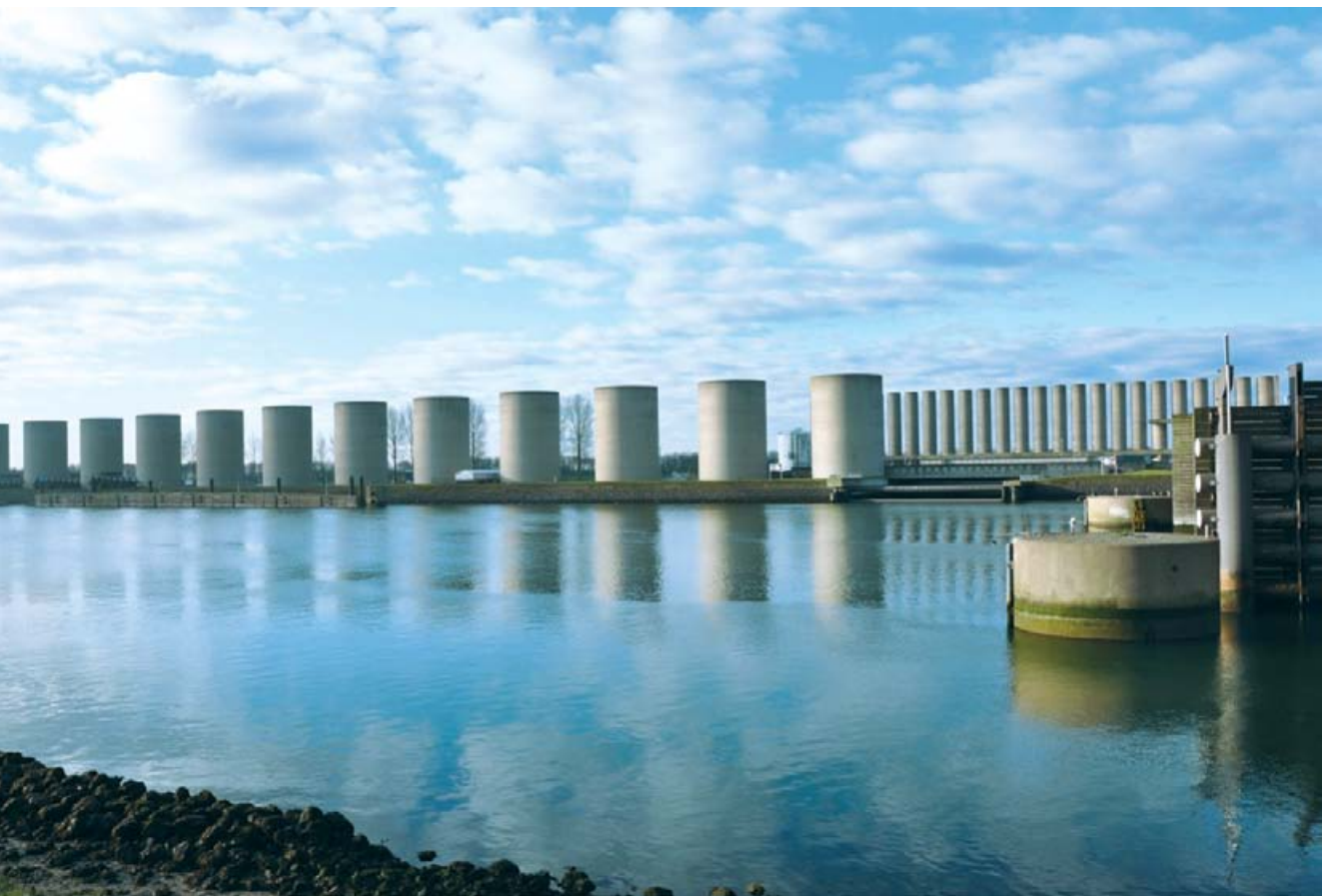
Slika 20: Protivetrna pregrada ob kanalu v Rotterdamu na Nizozemskem (Maarten Struijs).
