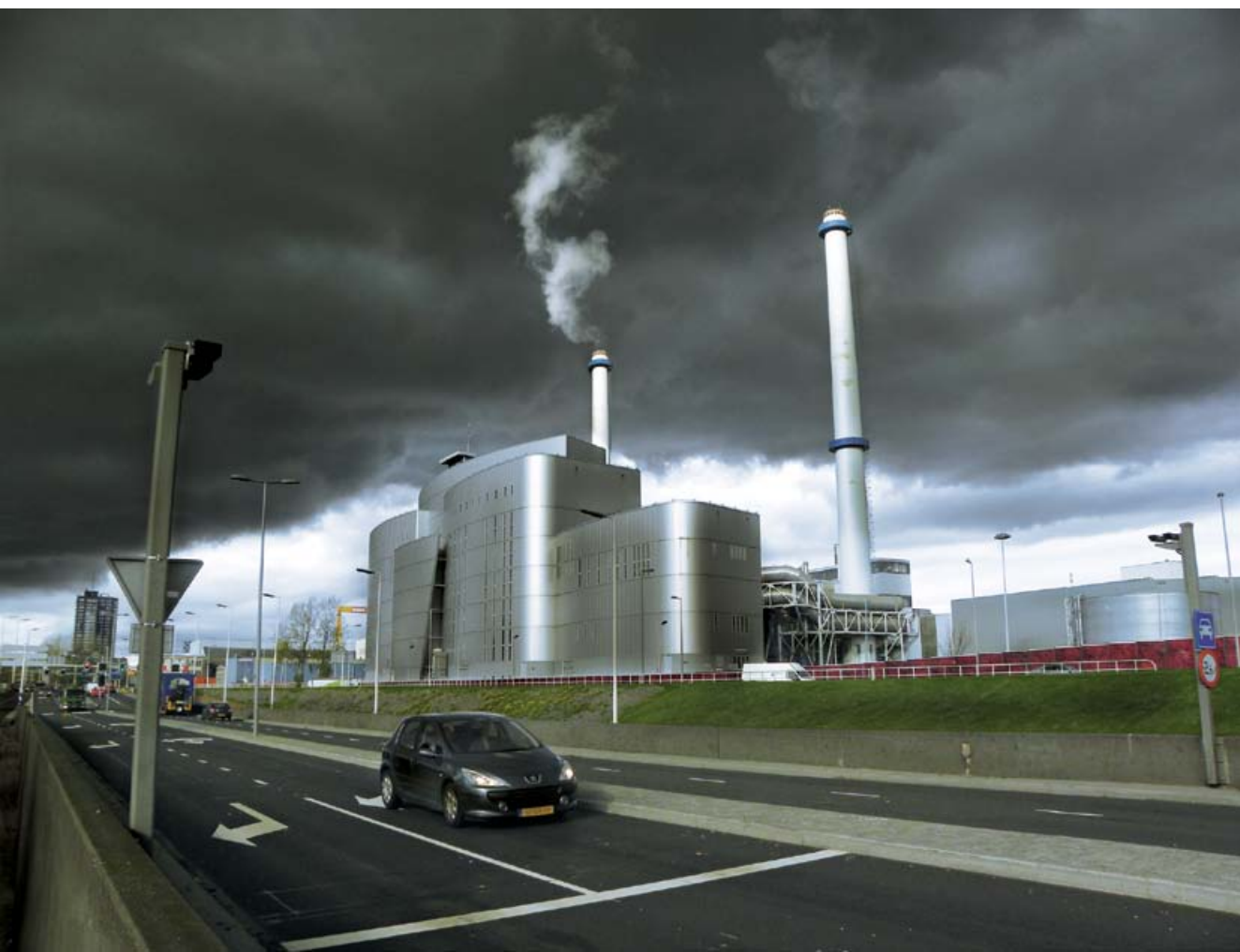
Slika 7: Čistilna naprava za zrak in vodo ob tunelu in reki Maas v Rotterdamu, Nizozemska (Maarten Struijs).
