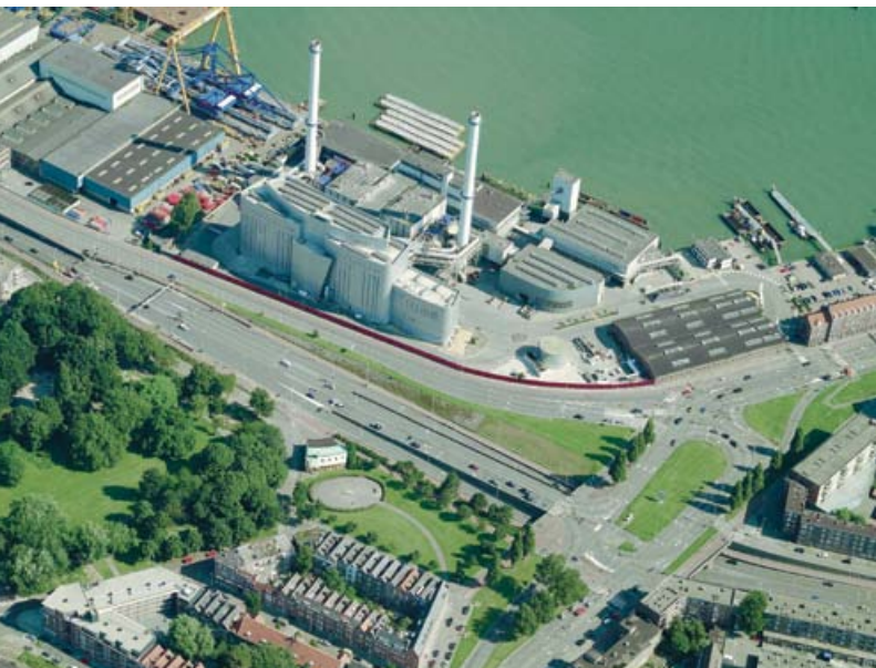
Slika 6: Čistilna naprava za zrak in vodo ob tunelu in reki Maas v Rotterdamu, Nizozemska (vir: BingMaps, februar 2013).
